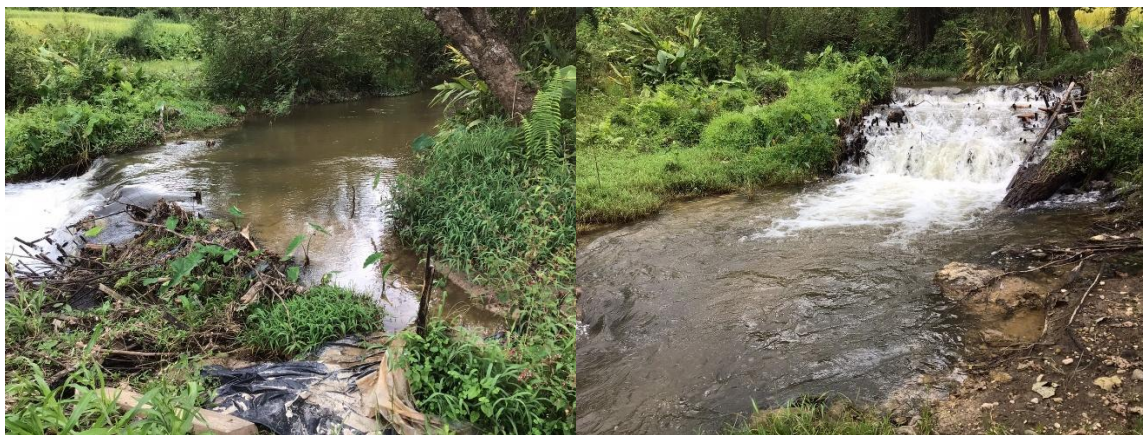
ภาพที่ 4.16 ฝ่ายกั้นน้ำ
